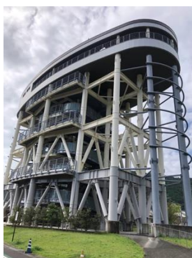
佐賀地区津波避難タワー
