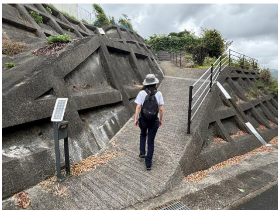
整備されたルート
